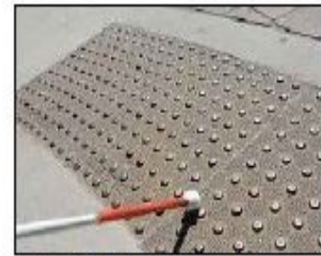
TACTILE WALKING SURFACE INDICATOR (TWSI) INDICATEURS TACTILES DE SURFACE DE MARCHÉ (ITSM)
