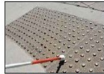
TACTILE WALKING SURFACE INDICATOR (TWSI) INDICATEURS TACTILES DE SURFACE DE MARCHÉ (ITSMI)
